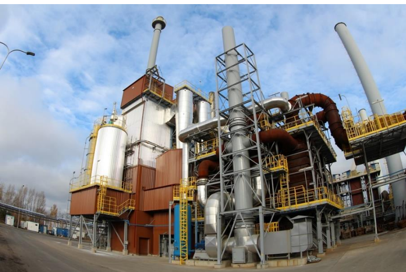
Odpylnia pieców anodowych HMG II
